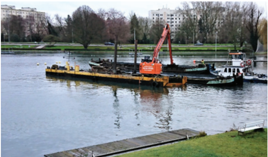
De baggerwerken ‘halverwege’ (20 december 2022)
