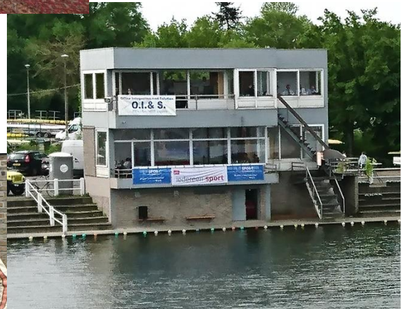
Voor de laatste maal met de aankomststoren , gebouwd in 1975
